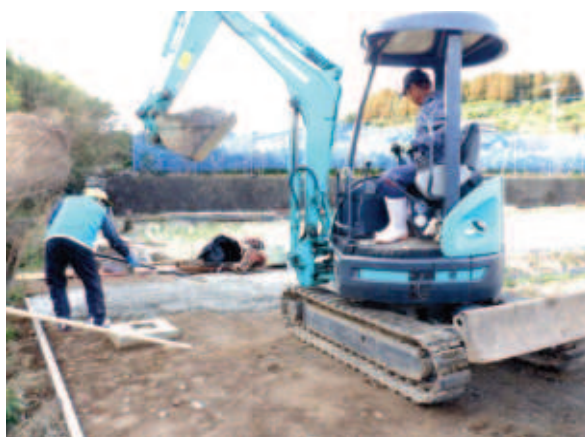
西塩屋区 未舗装農道を舗装
