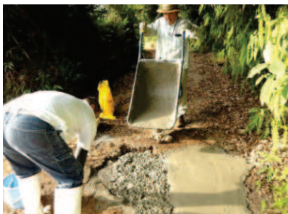
母ヶ浦区 破損施設の補修
