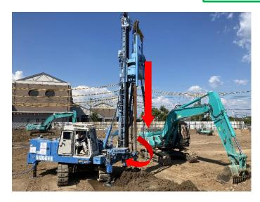
専用の機械を用いてドリルを土の中に挿入し、 ドリル先端から薬液 (セメント)を注入しながら ドリルを土の中で回転させ引き抜くことで、地盤 改良体を築造していきます。
