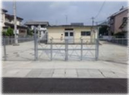
写真② 辻浄水場
