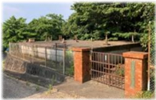
写真③ 七浦配水池
