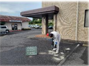
図6-7 漏水確認調査
