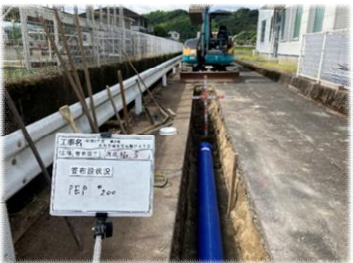
写真④ 耐震管路への布設替え
