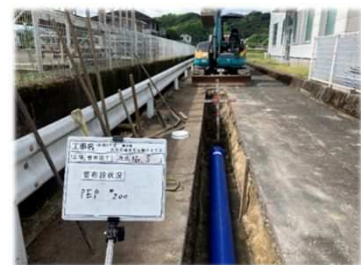
写真④ 耐震管路への布設替え
