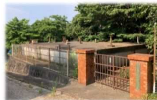
写真③ 七浦配水池
