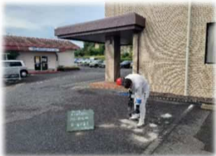
図6-7 漏水確認調査
