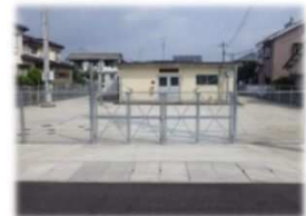
写真② 辻浄水場
