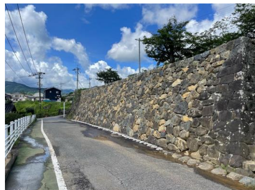
R5年度修理を行った 「鹿島城址にのこる松蔭神社 石垣」
