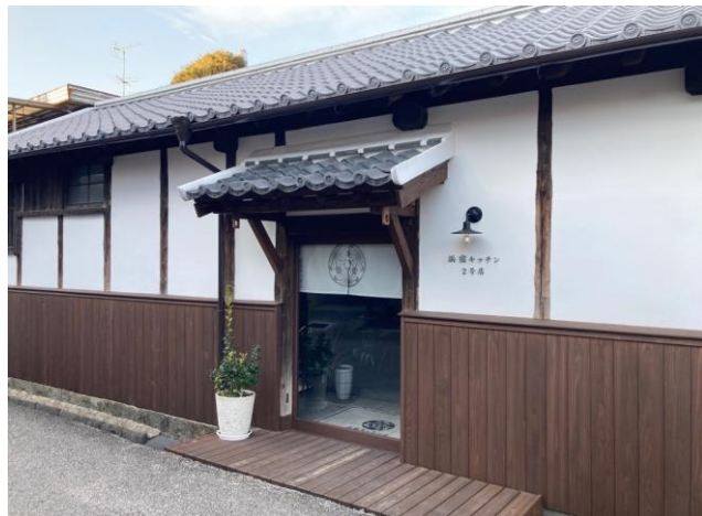
令和4年度 伝建事業にて修理を行った物件 飲食店として活用
