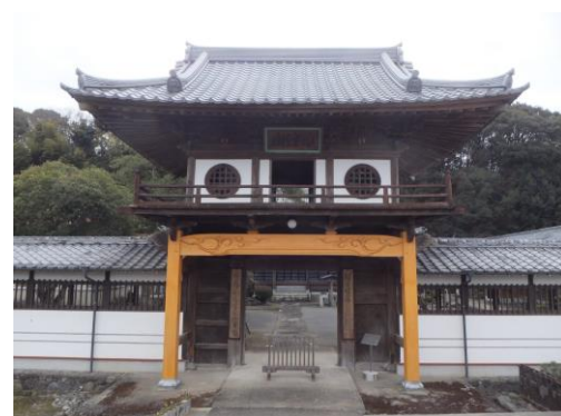
佐賀県遺産「永溪山泰智寺」 (平成31年度山門修理)
