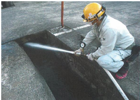
伝建地区内防災設備点検状況
