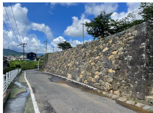
佐賀県遺産「鹿島城址にのこる松蔭神社」 (令和5年度 石垣修理)
