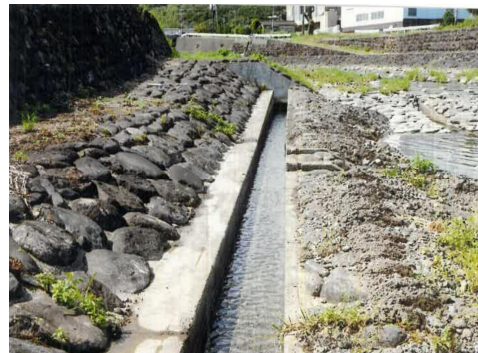
水路土砂堆積復旧(重機使用料)
