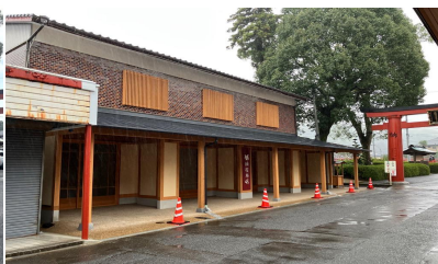
令和7年度 修景後 (建物)
