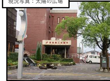
現況写真：太陽の広場
