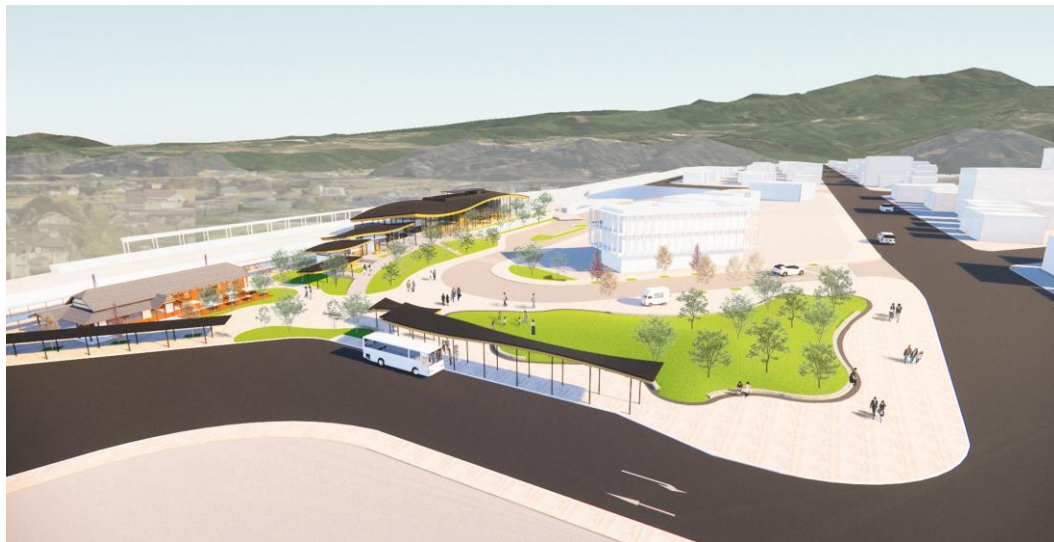
公共交通ロータリーより全景
