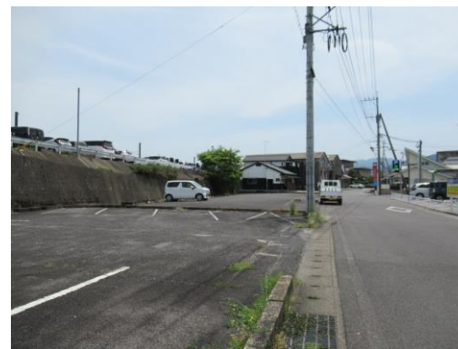
市営駐車場スロープ改修
