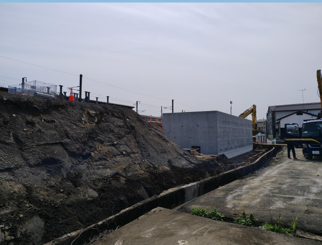
令和 8 年 3 月 新駅舎造成工事 擁壁・地盤改良
