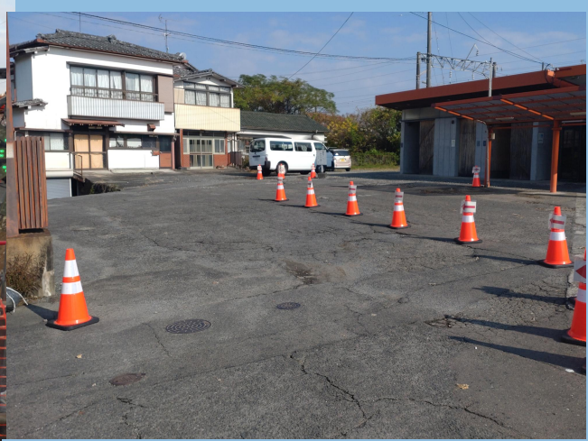
令和 7 年 11 月 駅前仮設ロータリー運用
