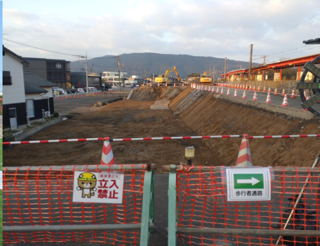
令和 7 年 11 月 新駅舎造成工事 擁壁・地盤改良
