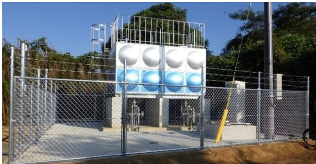
○山古賀配水池築造工事
