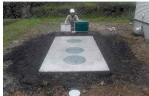
○浄化槽設置の竣工検査
