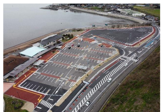
○道の駅鹿島整備事業【R6.3 完成】
