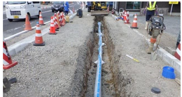
○国道207号(中牟田)道路改良工事に伴う 配水管新設・布設替及び消火栓布設替工事
