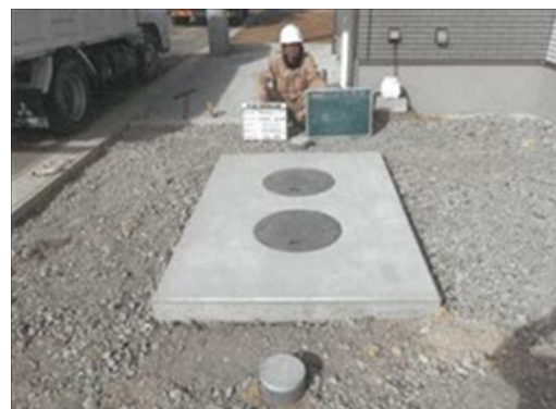
○浄化槽設置の竣工検査
