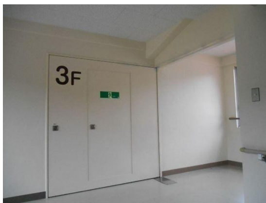
○古枝小学校 階段室3階防火扉 フロアヒンジ修繕
